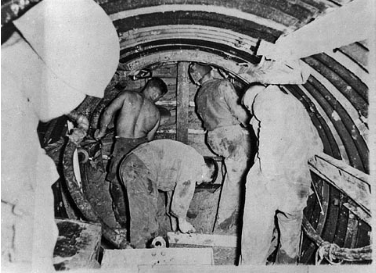
Foto aus der Sonderausstellung: Beim Tunnelbau.
