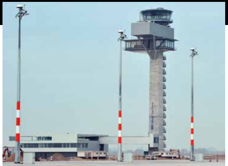
Der Tower des BBI ist äußerlich fertiggestellt. Jetzt geht's ans komplizierte „Innenleben“.
