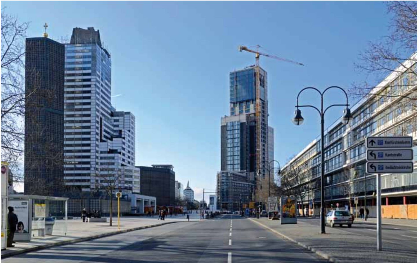
Im Westen viel Neues: links die alte Turmrüine der Gedächtniskirche, völlig eingerüstet, rechts das Bikini-Haus hinterm Bauzaun, und mittendrin das Zoofenster im Endspurt.
