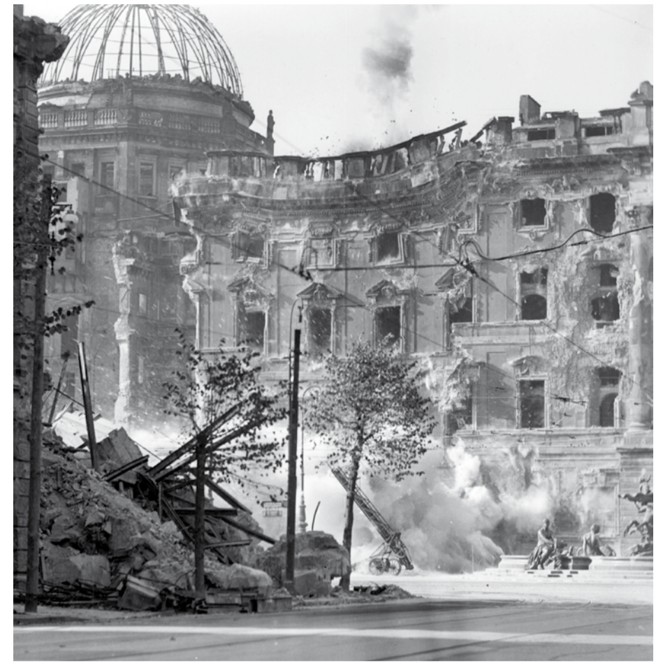
Abschied: Im Augenblick der Sprengung der Ruine des Stadtschlosses am 16. September 1950 sackt die Fassade in sich zusammen. FOTO: BLDAM
